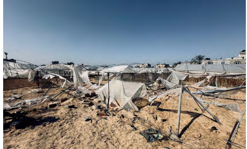
Serres détruites à Gaza
